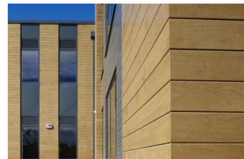
Gevel beneden: Accoyahout, verticale delen
